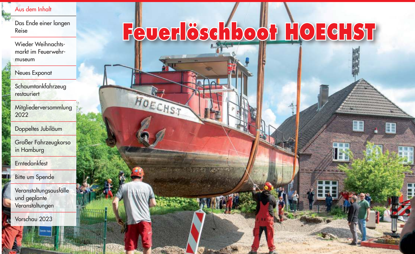
Bildunterschrift: Absenken des Feuerlöschbootes HOECHST in eine mit Kies gefüllte Baugrube, Foto: Dennys Mamero
