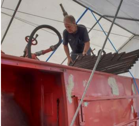
Andreas Vorgel demontiert den Holzboden auf dem Dach, Foto: Volker Pohlmann
