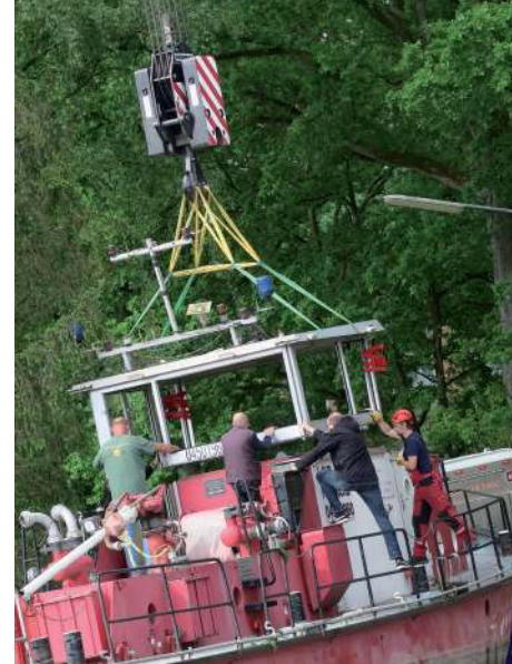
Montage des Daches, Foto: FMSH
