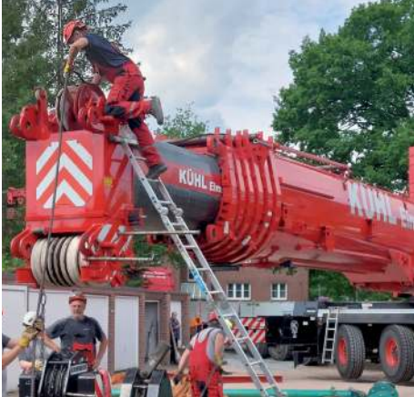
Montage des Kranhakens, Foto: Peter Lienau
