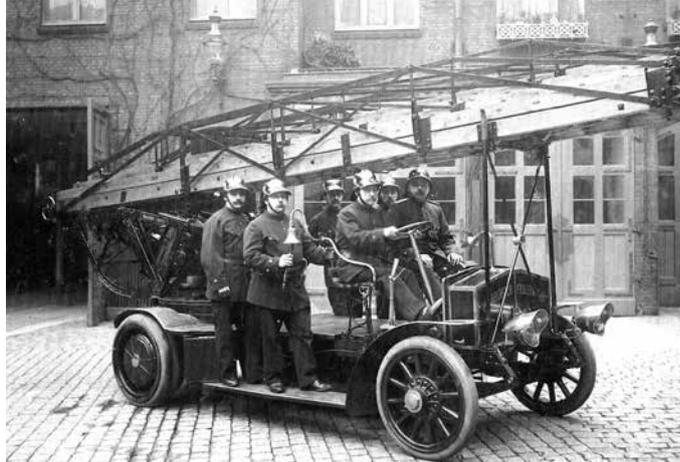
Magirus-Drehleiter mit batterie-elektrischem Antrieb der BF Hamburg von 1907, Foto: Archiv der Hamburger Feuerwehr-Historiker
